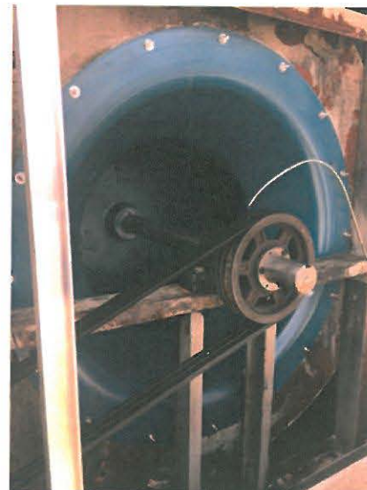
Repaired supply fan
